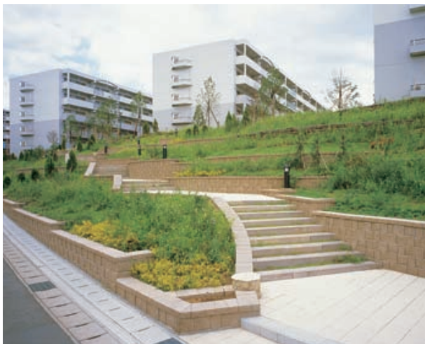
ストーンセレクト施工現場
